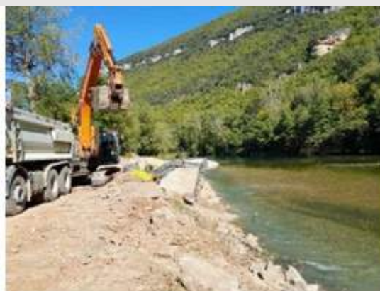
Terrassement des berges
