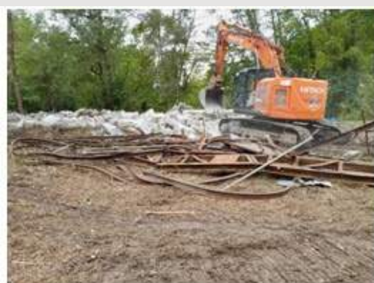
Démolition du bâtiment en ruine
